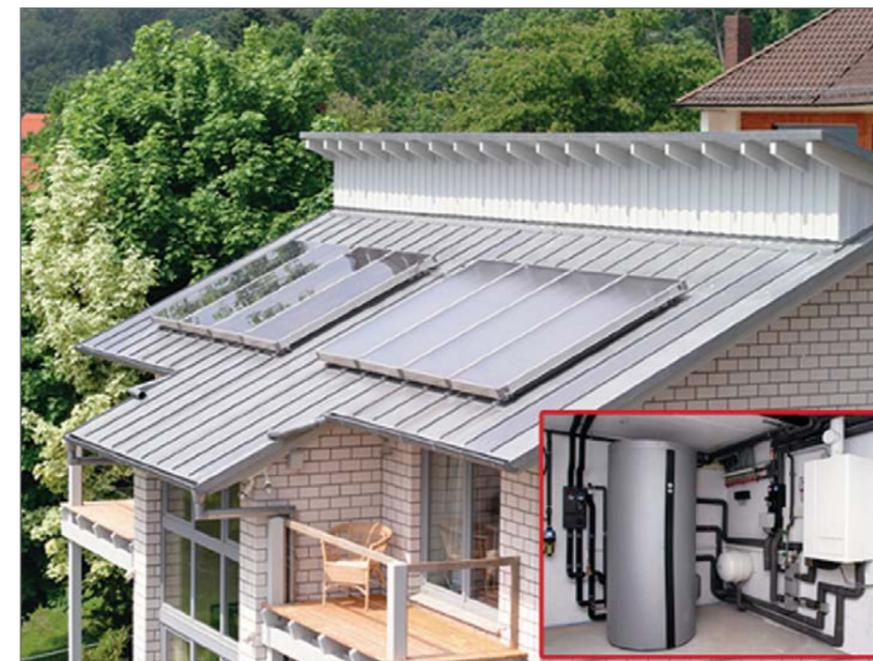
Ölbrennwert- und Solartechnik: Zusammen eine ideale Kombination zur Energie-Einsparung.
