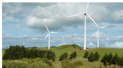
Projektbeispiel Te Apiti: 55 Windturbinen unterstützen die Energiewende in Neuseeland.
